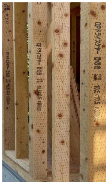
非通気構造における保存処理柱の採用事例
