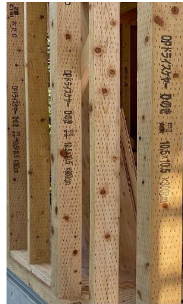
非通気構造における防腐柱の採用事例
